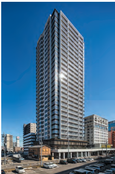
高崎駅東口第九地区
