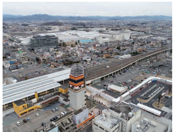
図6 整備された太田駅南口駅前広場
